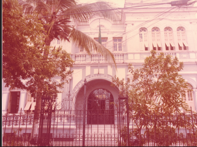
Figura 10 – Fachada do Hospital Naval de Salvador – Largo de Nazaré, Salvador
