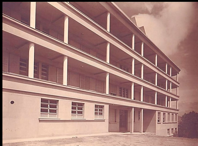
Figura 8 – Pavilhão Dr. Carlos Frederico, varandas
