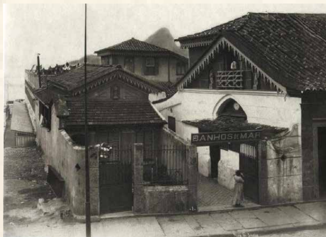
Figura 7: Casa de banho na Rua Santa Luzia - Rio de Janeiro.
