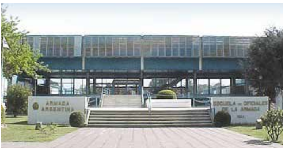
Figura 1 – Fachada Principal da ESOA
