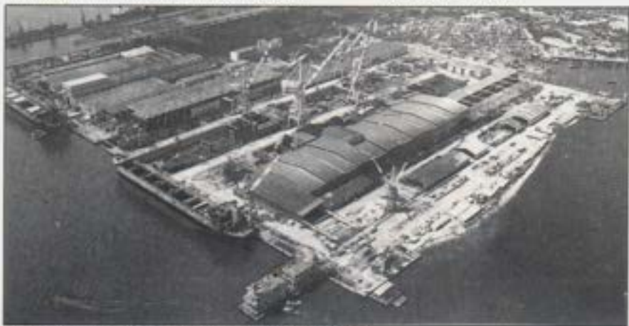
Vista aérea do Estaleiro na Ponta do Caju, Rio de Janeiro.
