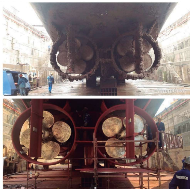
Figura 7 – Montagem da linha de eixo
