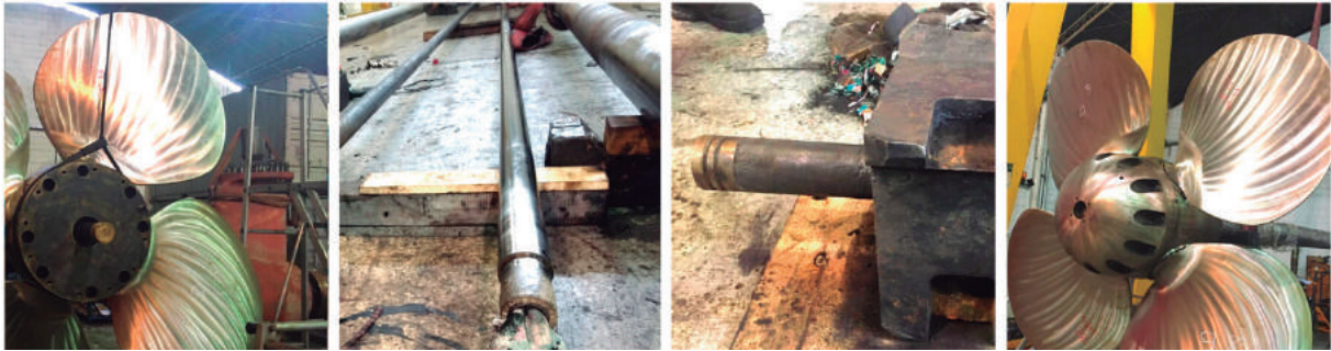
Figura 5 - Montagem da linha de eixo
