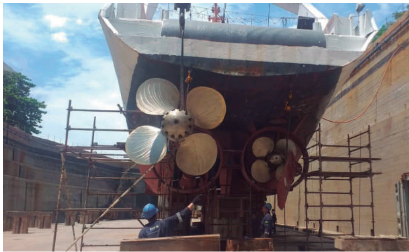
Figura 6 - Montagem da linha de eixo
