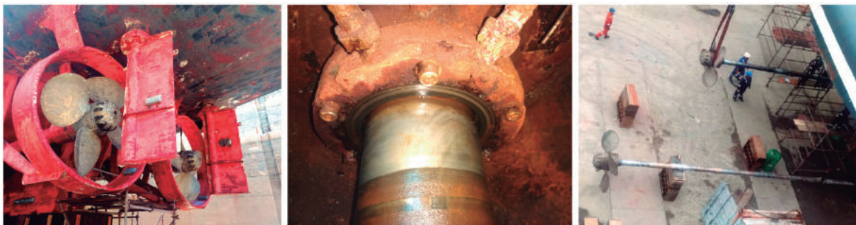
Figura 4 - Desmontagem da linha de eixo
