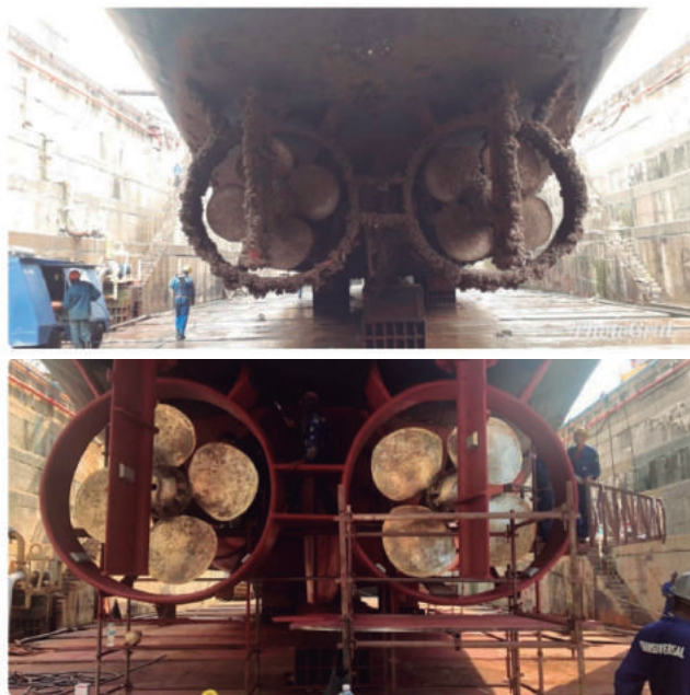
Figura 7 - Montagem da linha de eixo
