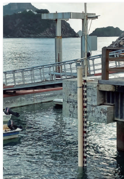
Figura 4 – Régua instalada na parte externa do cais
