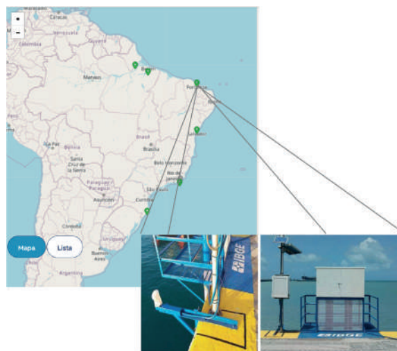
Figura 2 – Estação EMFOR que pertence à RMPG do IBGE. Fonte: Elaborado pelos autores (2023)
