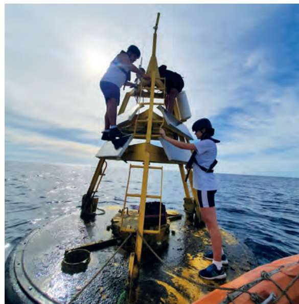
Figura 3 – Faina de manutenção em boia do projeto PNBOIA
