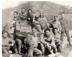
Figura 27: Tomada de Monte Castelo
