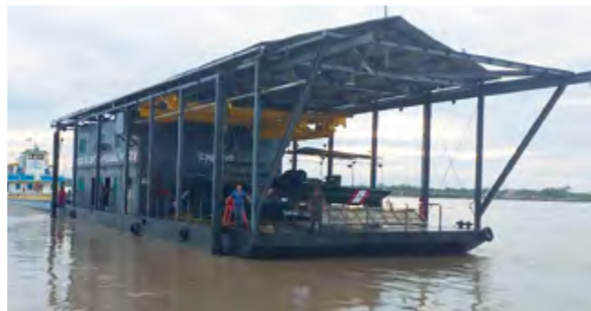
Figura 5: Estrutura flutuante de uma Unidade de Controle Fluvial
