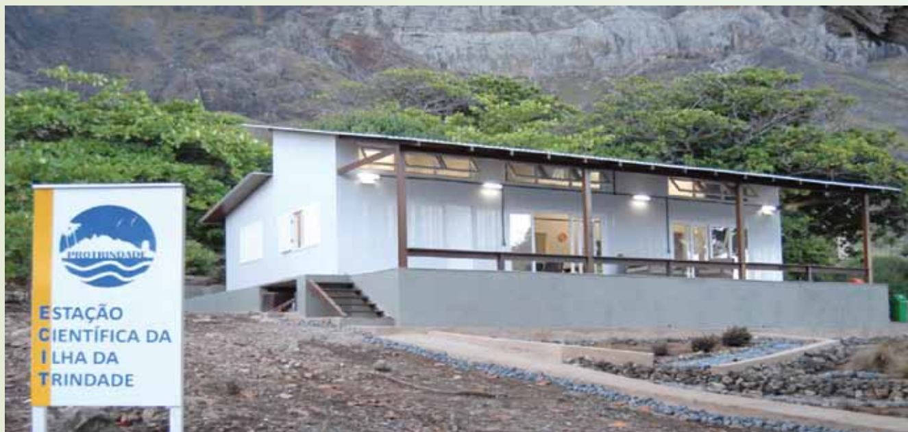
Figura 3 – Estação Científica da Ilha da Trindade – 2010. Fonte: SECIRM, 2010.
