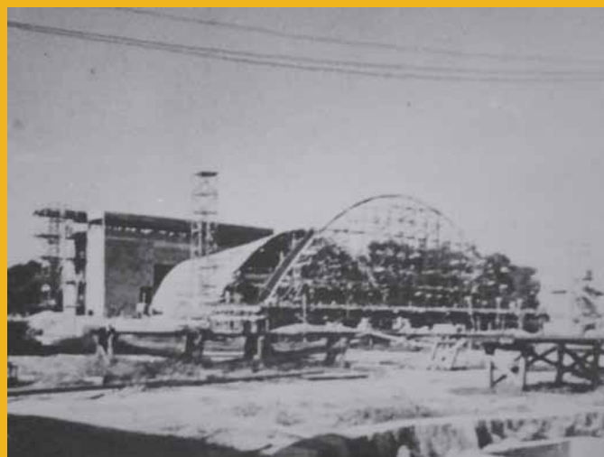
Construção do Auditório e da Escola de Música.
