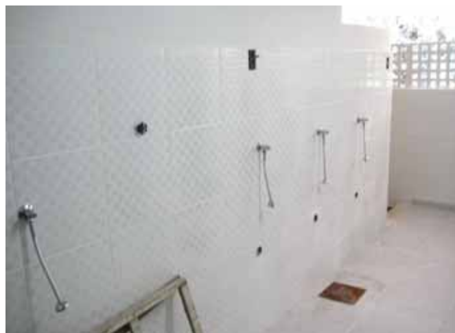
Reforma dos banheiros.
