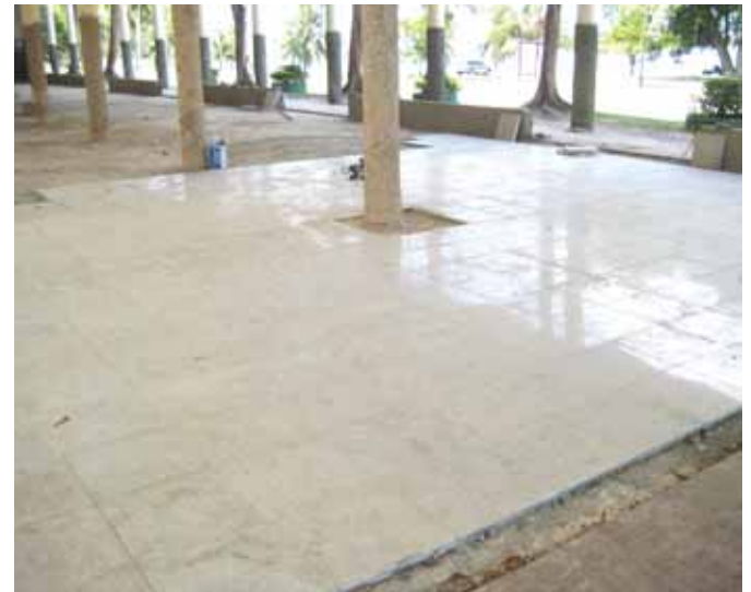
As fotos acima apresentam a obra de ampliação do refeitório de CB/SD.
