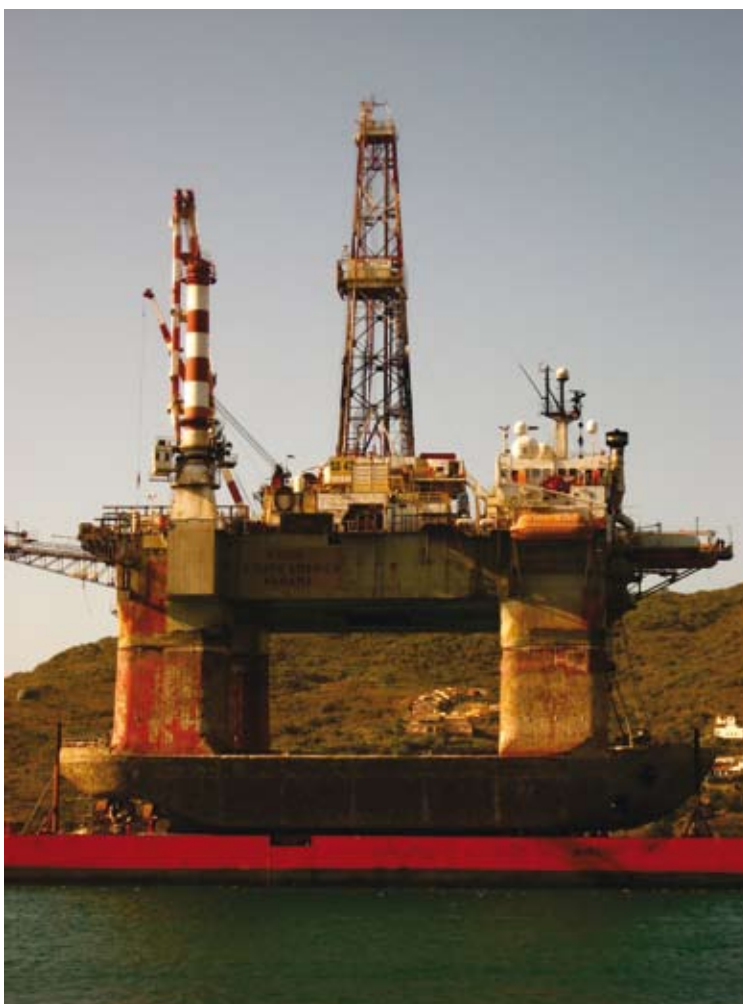
Figura 1 - Foto de uma plataforma rebocada para o porto do Forno em Arraial do Cabo para manutenção e troca de estruturas.
