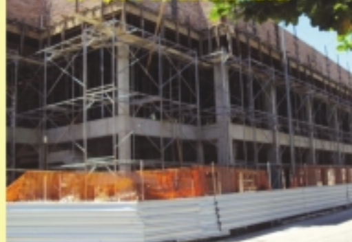
Fiscalização da construção do Prédio de Apoio da Escola Naval
