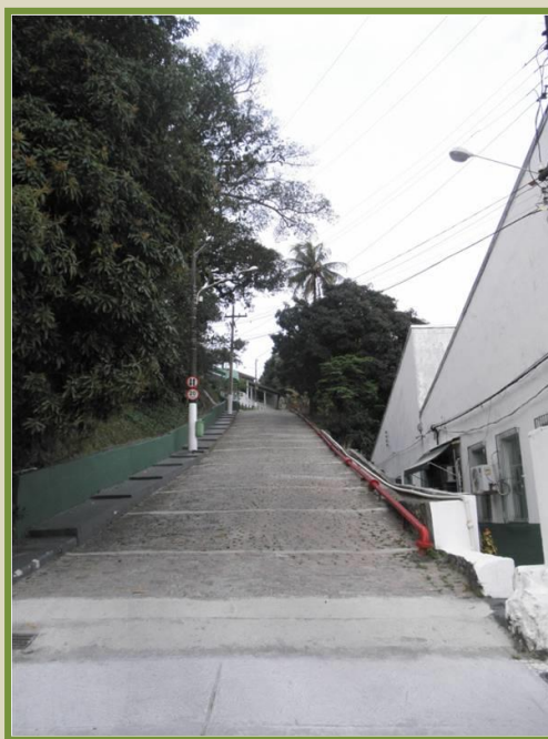
Obra da rede elétrica DEPOIS
