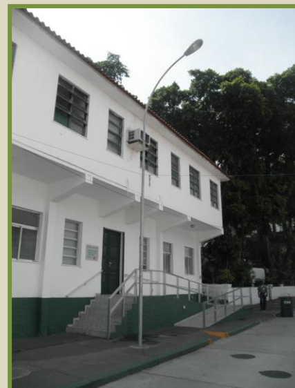
Instalação de postes de luz
