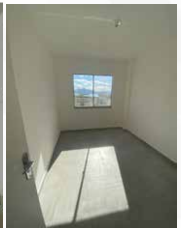
Manutenção no CHaPA
