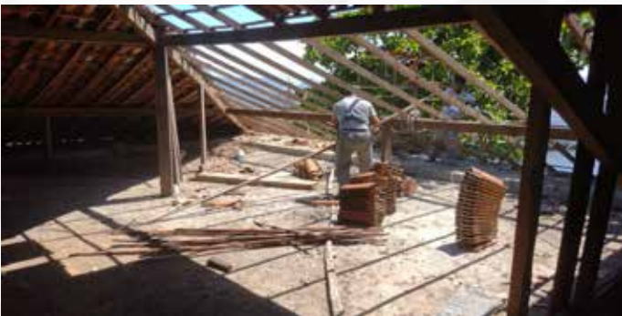
Manutenção no teto do Rancho
