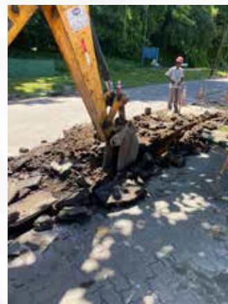
Manutenção na via de acesso ao CNPA
