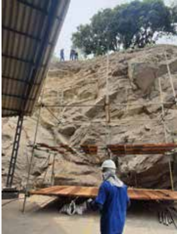
Estabilização da encosta
