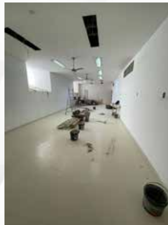
Manutenção no Alojamento de Oficiais
