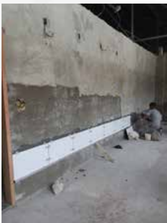
Manutenção no Alojamento 2°SG/3°SG
