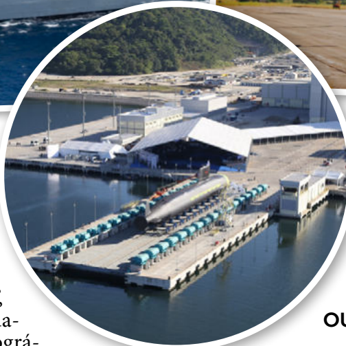
Estaleiro de construção na Base de Submarinos na Ilha da Madeira
