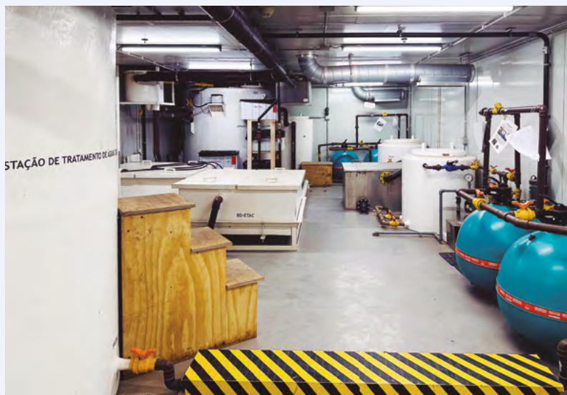
Compartimento de tratamento de água, cinzas e esgoto
