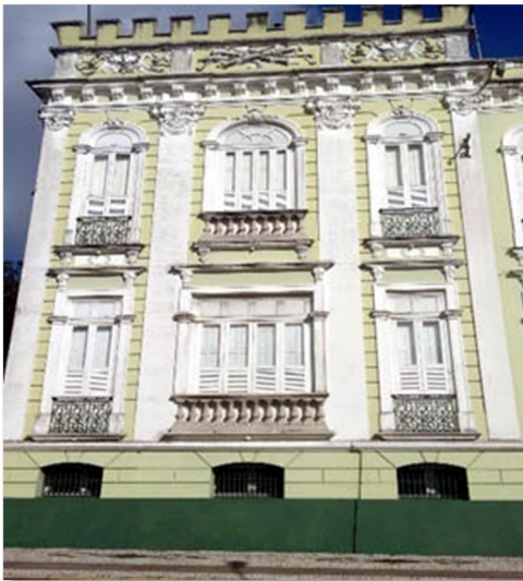
Fig. 9 – Fachada do Quartel General.
