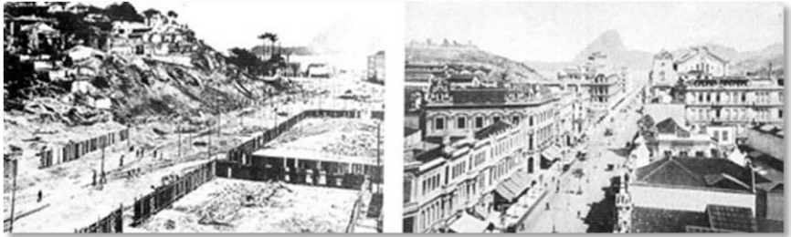
Fig. 3 e 4 – Construção da Avenida Central
