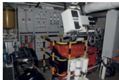
Praça de Máquinas
