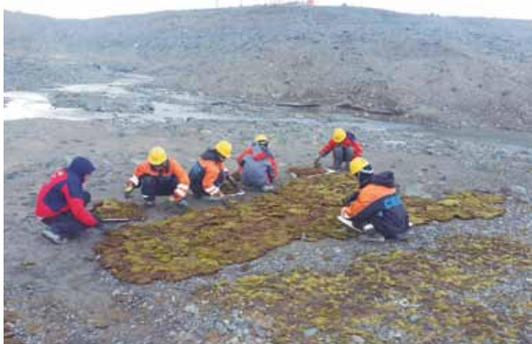
Transplante do musgo retirado do local onde será construída a área de pouso
