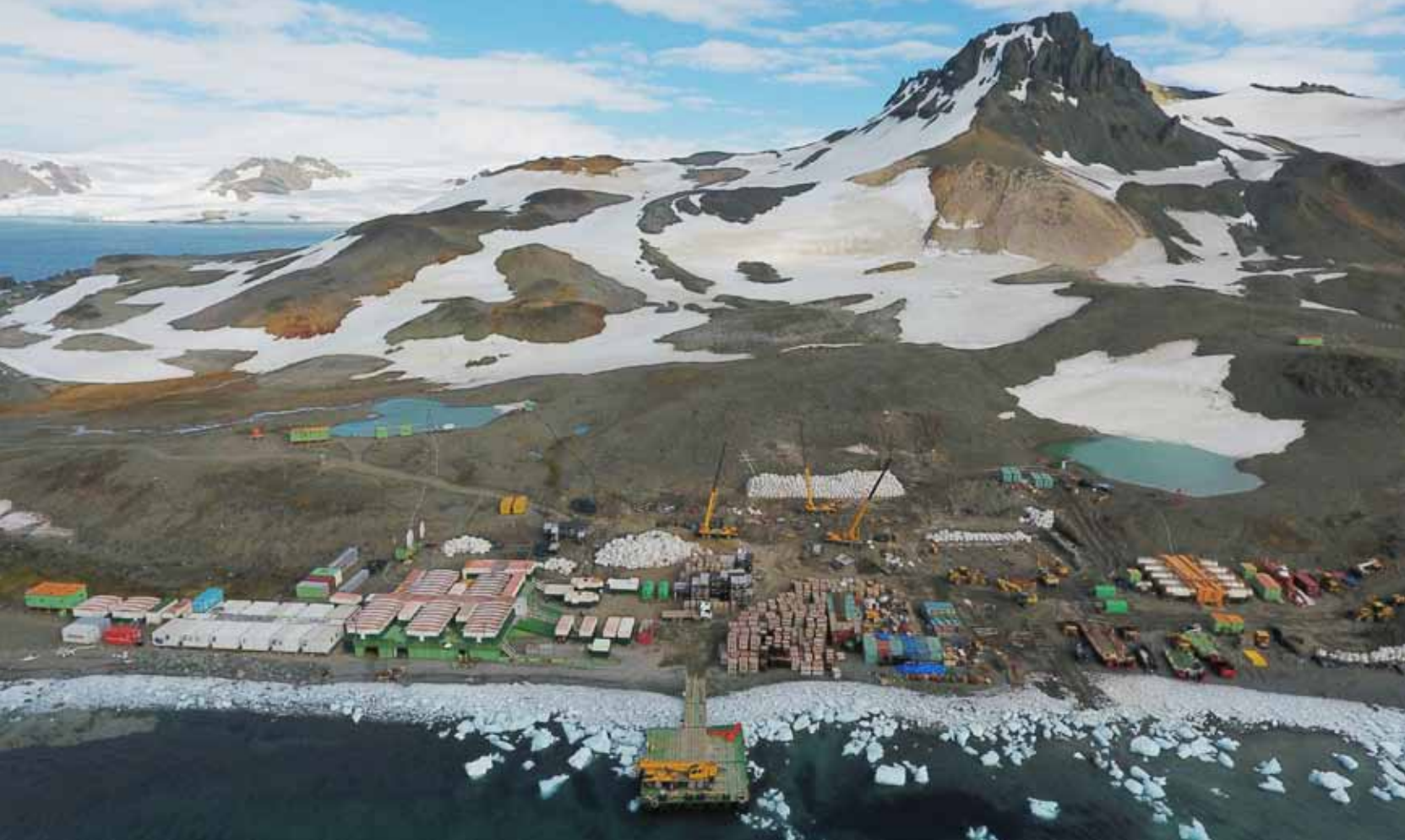
Vista aérea do canteiro de obras
