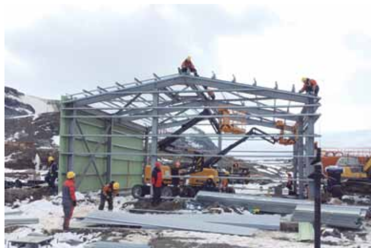
Colocação dos painéis de fechamento do abrigo
