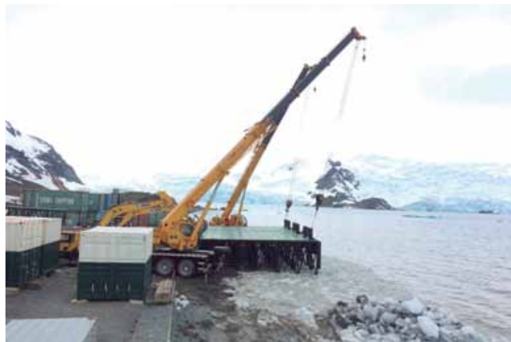
Montagem da plataforma
