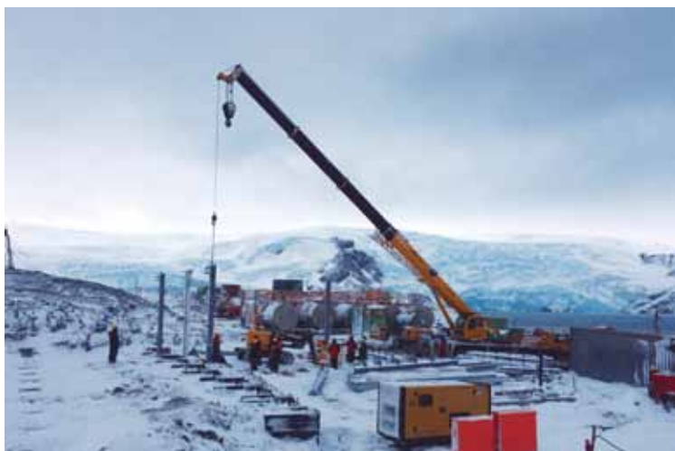
Início da montagem do abrigo para as viaturas
