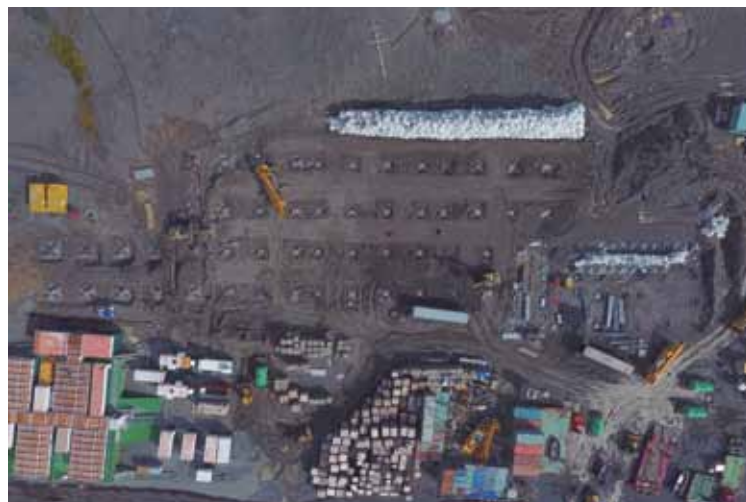
Vista aérea após a implantação de toda a fundação do prédio principal da nova EACF
