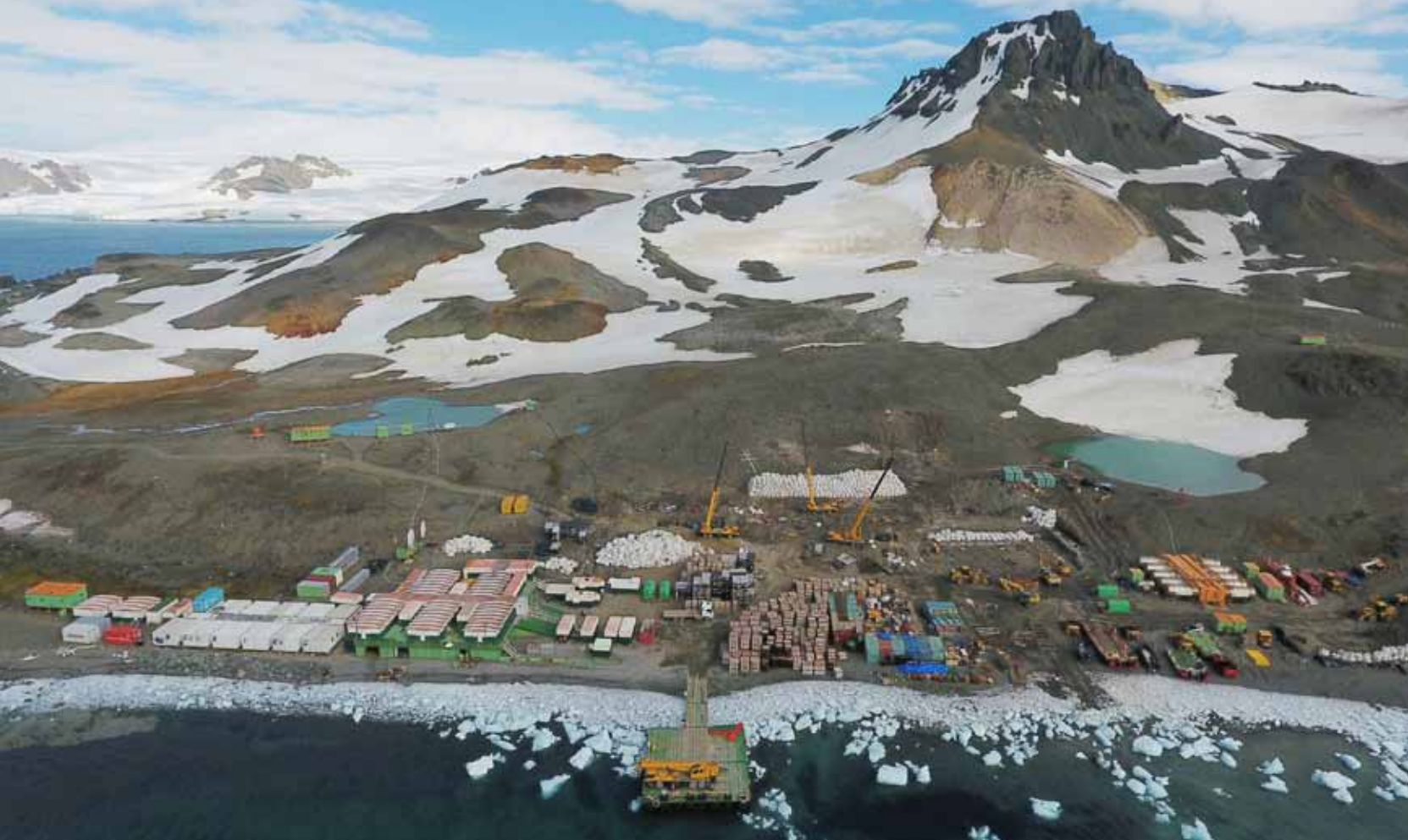
Vista aérea do canteiro de obras
