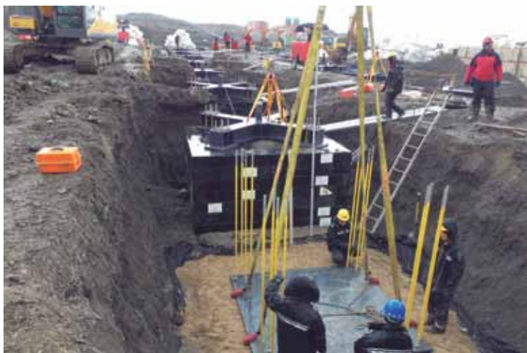
Processo de montagem dos elementos que compõem os blocos de fundação
