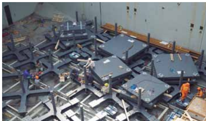
Foram embarcados materiais como: 12 equipamentos automotores, duas balsas, um landing craft, e cerca de 5.000 itens como containers, estruturas metálicas e esquadrias
