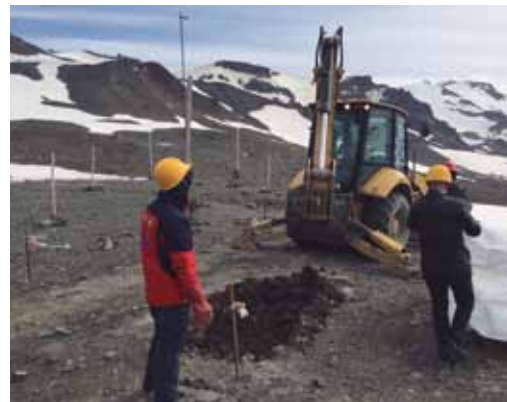
Escavação do solo para realização de ensaio PLT
