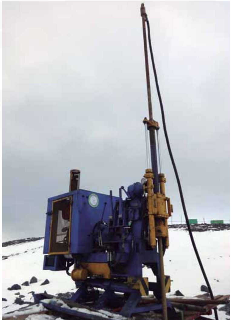
Realização de sondagem rotativa durante as prospecções geotécnicas, realizadas em 2014
