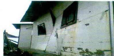
Avarias causadas pelo impacto das ondas na Estação Científica do ASPSP
