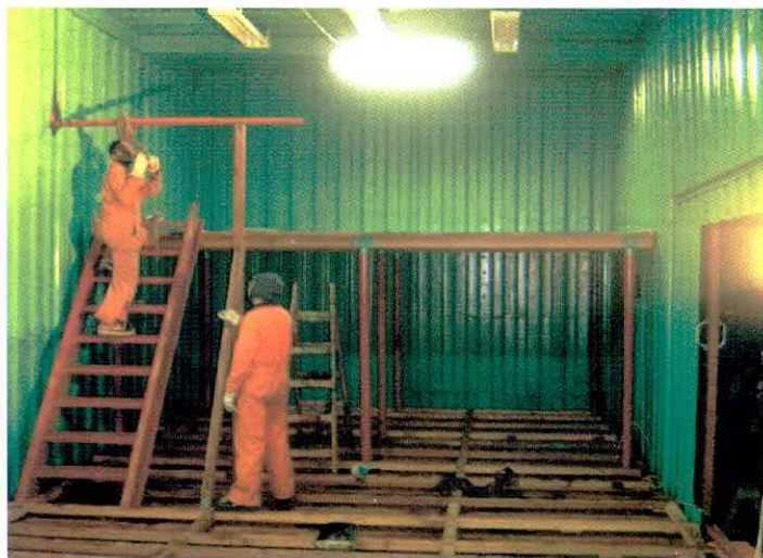
Construção do novo paiol
