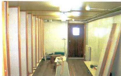
Reforma da sala de secagem
