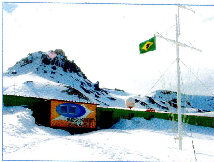
Acima, nova frente da estação, inaugurada em 2004. À esquerda, EACF vista do alto.
