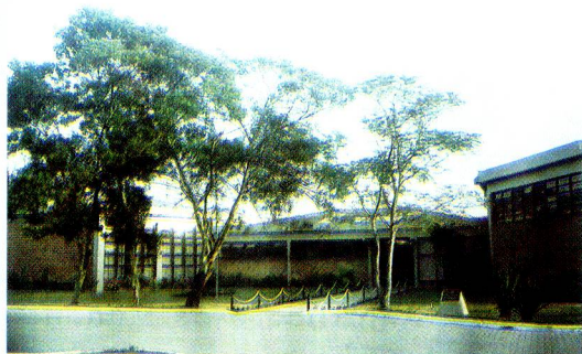
Vista frontal da Estação de Apoio Antártico - ESANTAR
