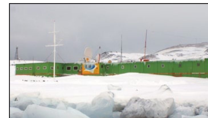
EACF em 2011. Após reformas e ampliações a antiga Estação alcançou 2.300m 2
