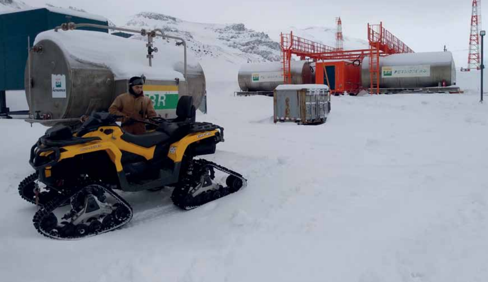
Tanques de óleo diesel ártico - combustível especialmente desenvolvido pela PETROBRAS para o PROANTAR, com aditivo anti-congelante, para uso até -39°C
