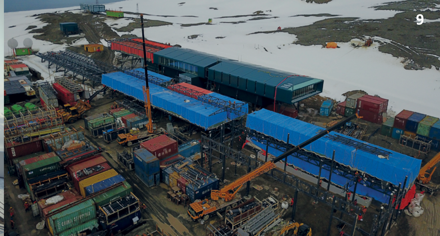
Estágio atual da reconstrução, EACF novembro de 2018
