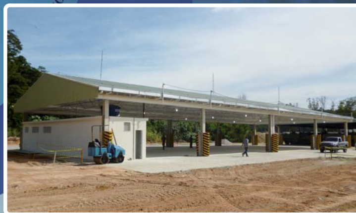
Construção de Galpão para Carros de Combate - BtIBIdFuzNav
