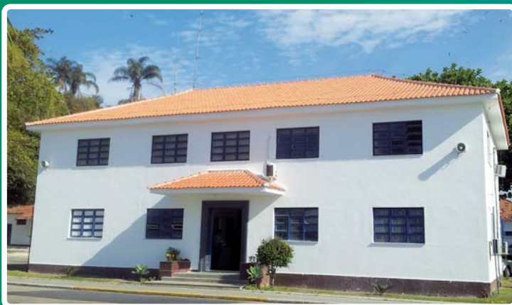
Reforma de Telhados - ERMRJ
