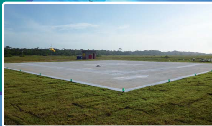
Construção de Heliponto em Itaóca/ES - BFNIF
