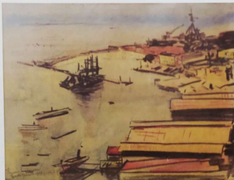
Capa – Construção do Arsenal de Marinha na Ilha das Cobras, na década de 1920. Aquarela de Bruno Lechowski (1933).
