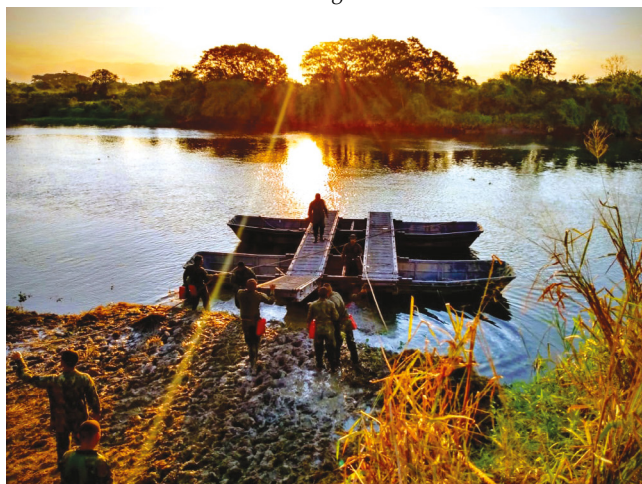
Montagem da Portada Leve “Castor”
