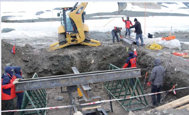
Foto 6 - Montagem da estrutura para a realização do primeiro ensaio PLT e detalhes de alguns dos equipamentos/instrumentos utilizados.
