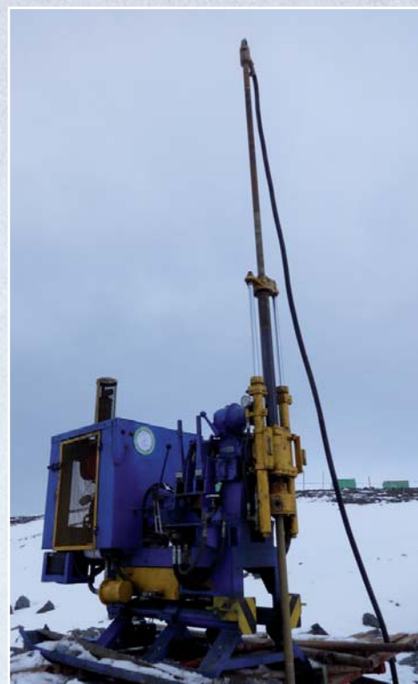
Foto 3 - Perfuratriz utilizada nas investigações preliminares.
