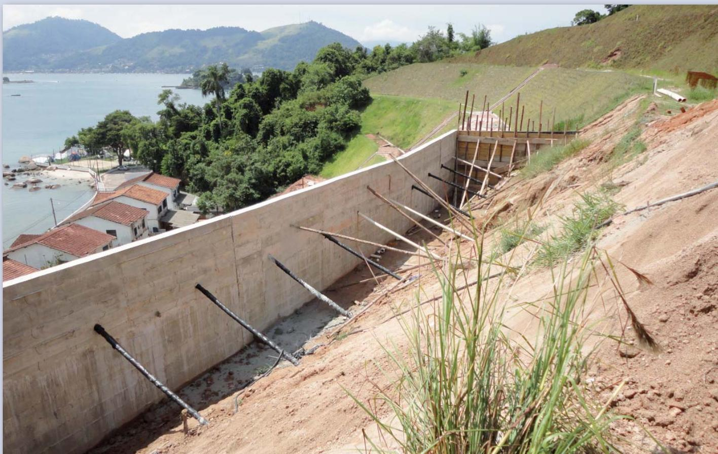
Figura 4 - Vista da instalação dos DHPs.
