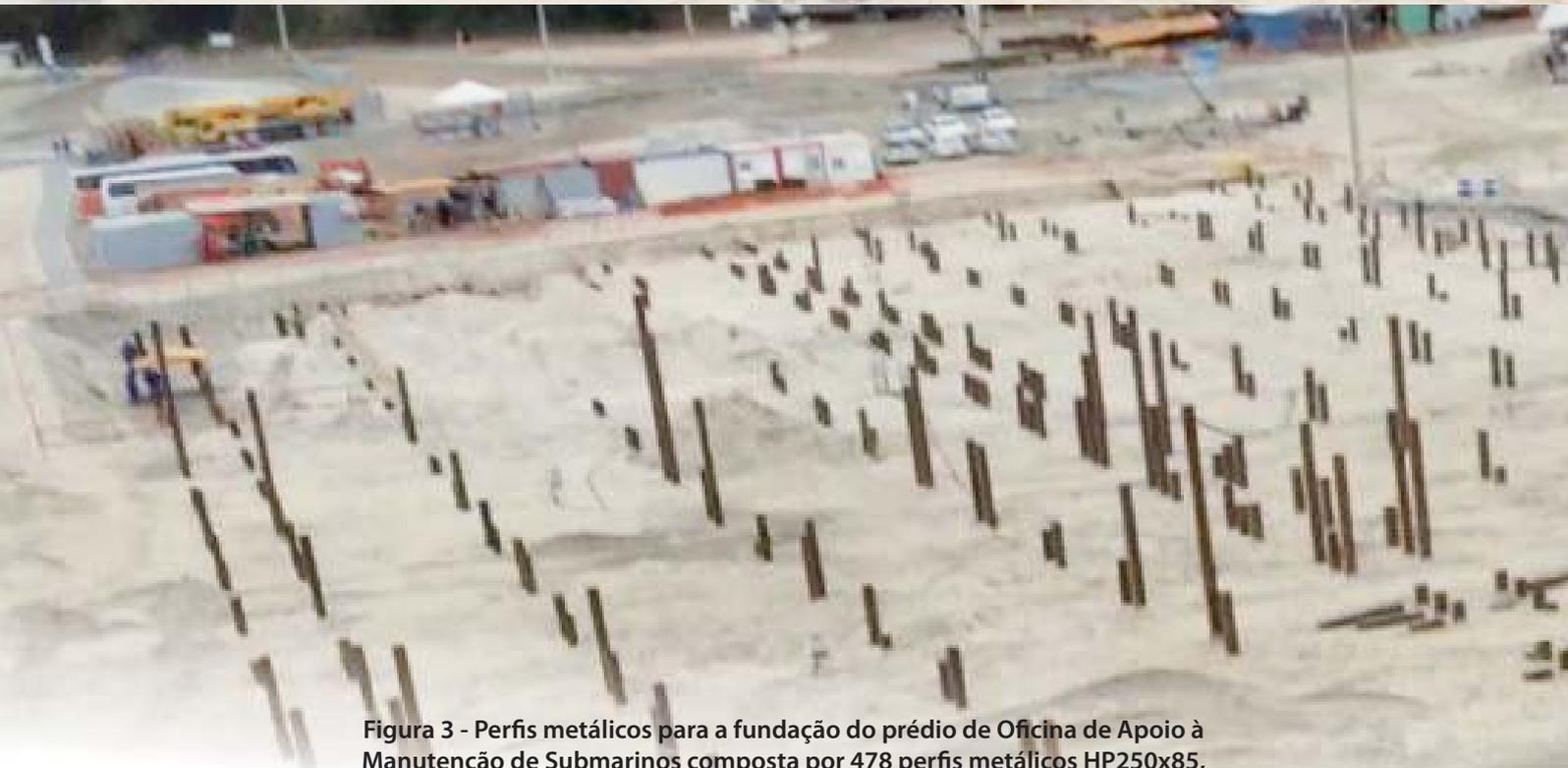
Figura 3 - Perfis metálicos para a fundação do prédio de Oficina de Apoio à Manutenção de Submarinos composta por 478 perfis metálicos HP250x85, totalizando mais de 14 quilômetros de comprimento e 1000 emendas.
