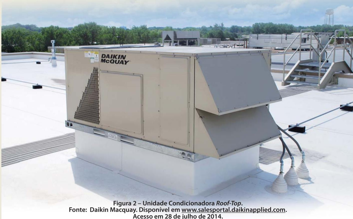
Figura 2 – Unidade Condicionadora *Roof-Top*.
