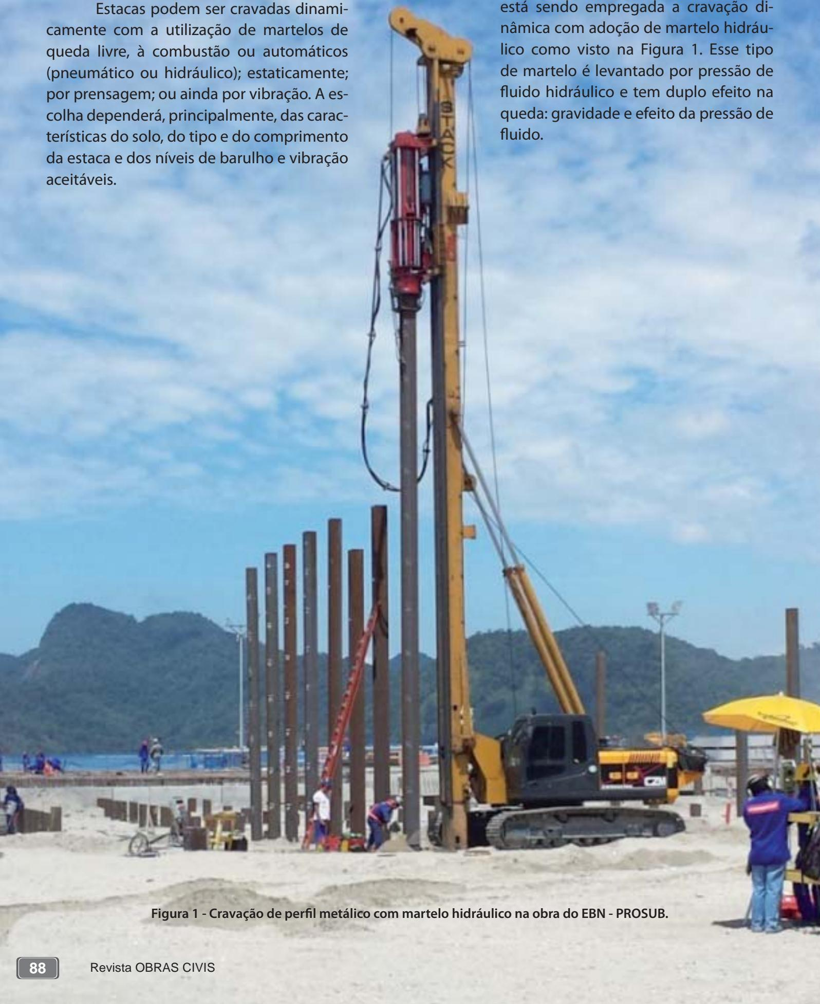
Figura 1 - Cravação de perfil metálico com martelo hidráulico na obra do EBN - PROSUB.
