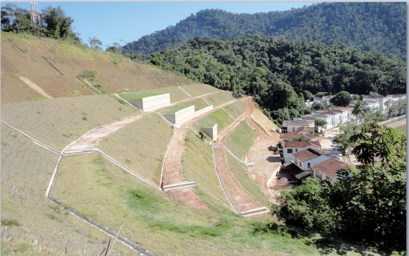
Figura 5 - Vista do sistema drenagem superficial (canaletas, escadas hidráulicas e caixas coletoras).
