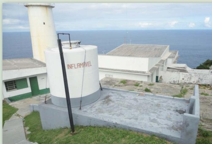
Figura 8 - Tanque primário de recebimento e armazenamento do óleo diesel do Farol de Cabo Frio.
