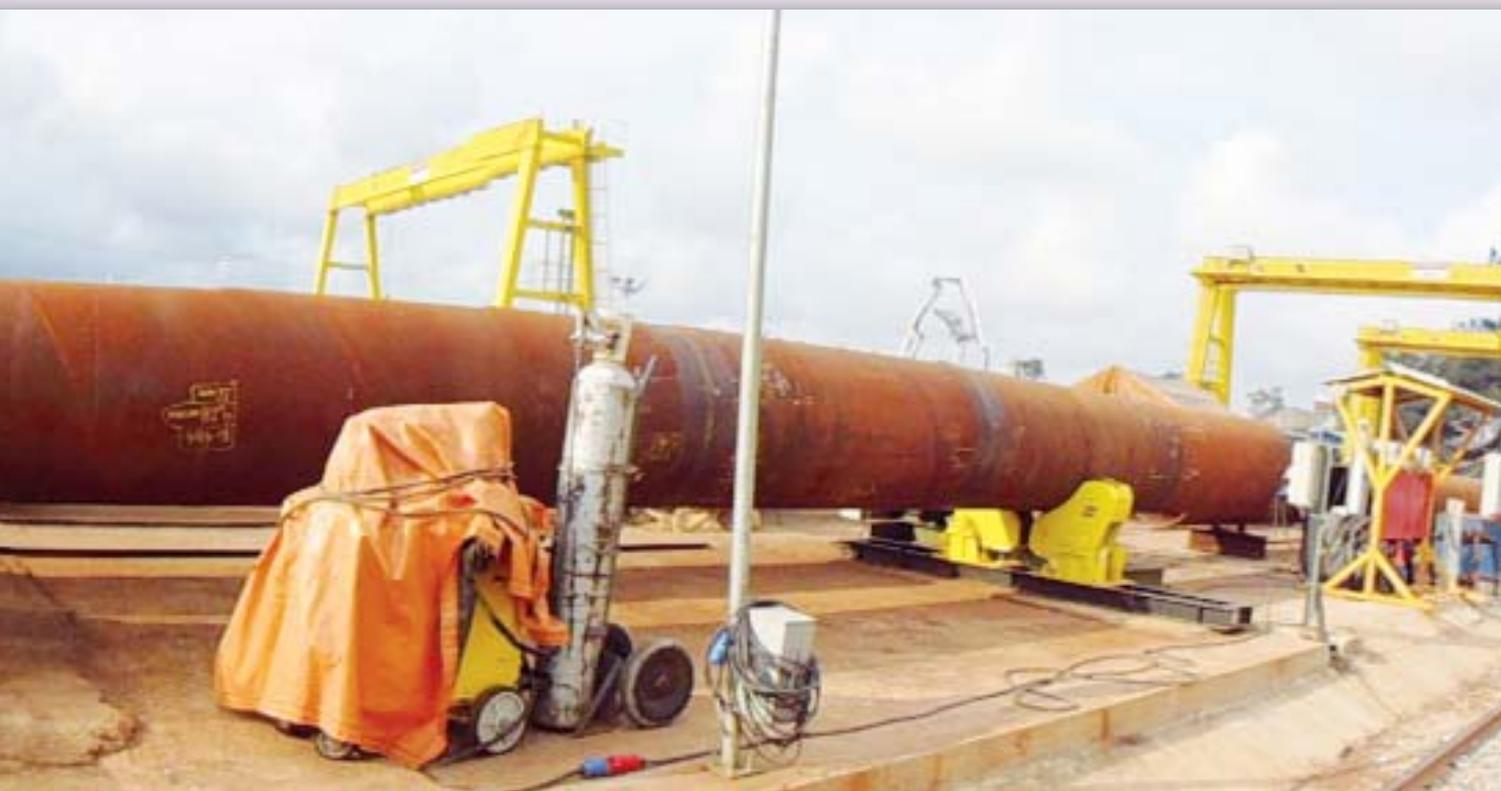
O comprimento de cada estaca varia entre 30 e 52 metros e há no interior das camisas metálicas um preenchimento de concreto armado, somente até a profundidade necessária para resistir aos momentos fletores impostos. O concreto, introduzido através de funil após a dragagem do interior e colocação da armadura, possui  $f_{ck} \geq 40$  MPa (Figura 4).
