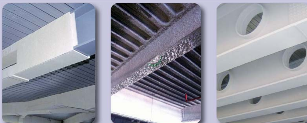
Figura 1 – Proteções passivas usuais: placas de silicato de cálcio, argamassa projetada e revestimento intumescente (da esquerda para a direita).
