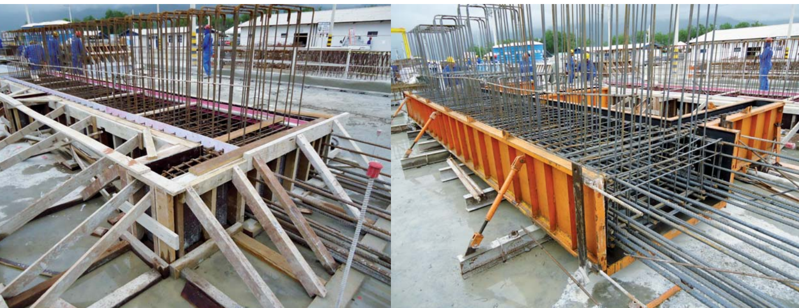
Figura 2 – Montagem com forma de madeira (à esquerda) e forma metálica (à direita).
