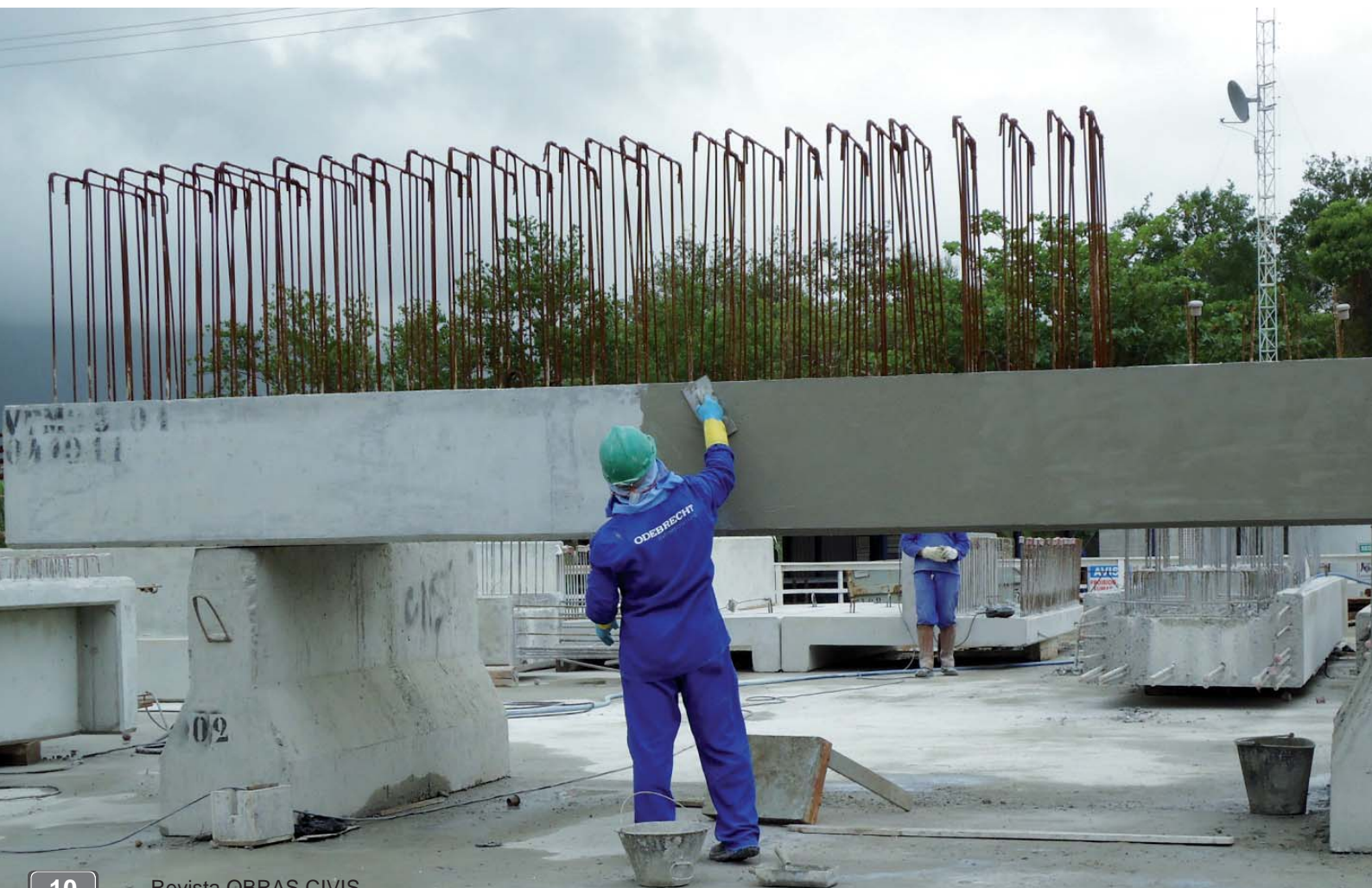
Figura 5 – Regularização da superfície após tratamento.
