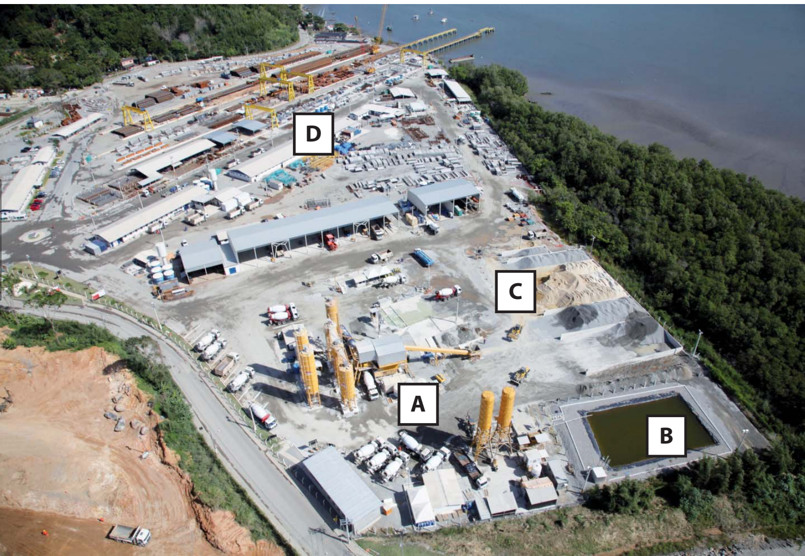
Figura 1 – Fotografia aérea da Área Norte.
