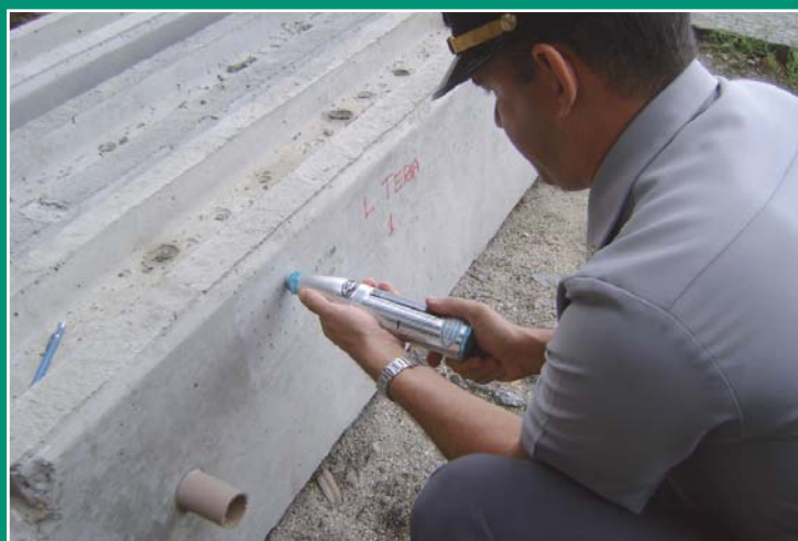
Foto 1 - Ensaio sobre estaca-prancha da obra de recuperação do Cais da Bandeira - Com1ºDN - RJ
