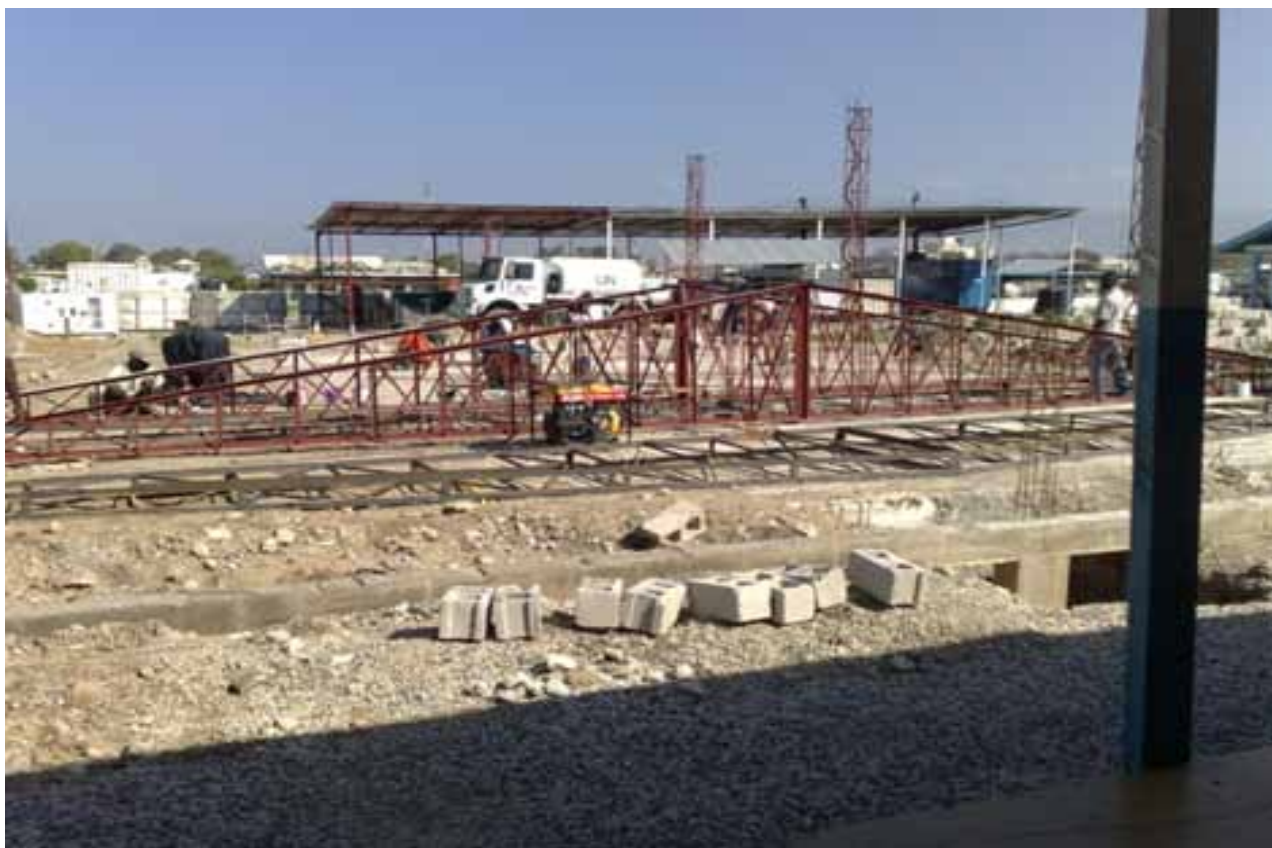
Obras de Construção da Tenda da Paz
