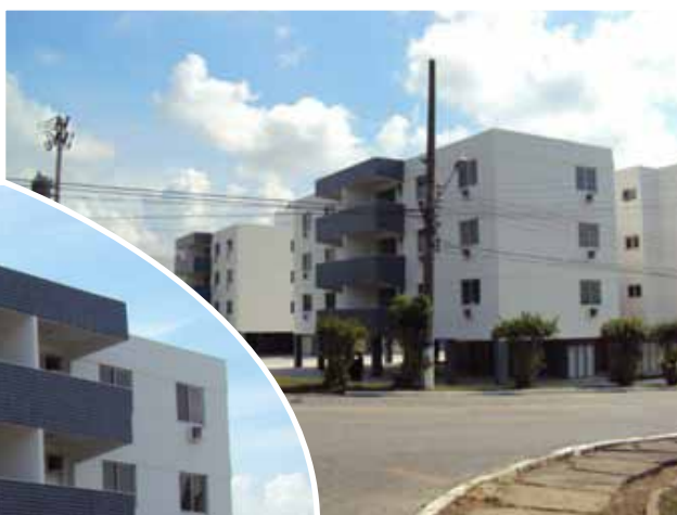
Edifícios Tamoio I, II e III
