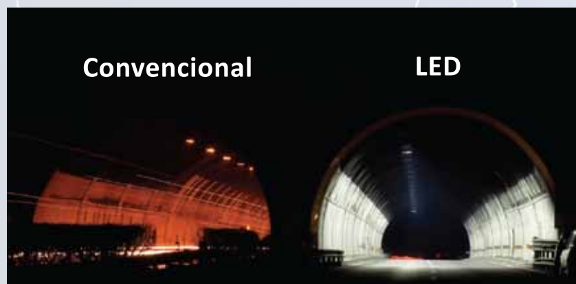
Foto 4 – Túnel Crocina, na Cidade de Arezzo – Itália (Fonte: Beta LED)
