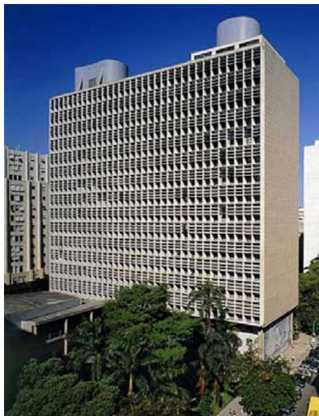
Figura 2 – Arquitetura Moderna. Antigo Ministério da Educação e Saúde. Fonte: Arquitetura Contemporânea no Brasil .
