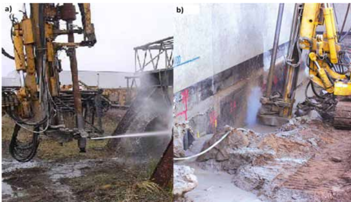
Figura 5 – Equipamento utilizado para execução de colunas e painéis em Jet Grouting: a) Jato horizontal de alta pressão; b) Versatilidade para execução de reforços próximos a estruturas existentes (Fonte: Bilfinger Berger Foundations).
