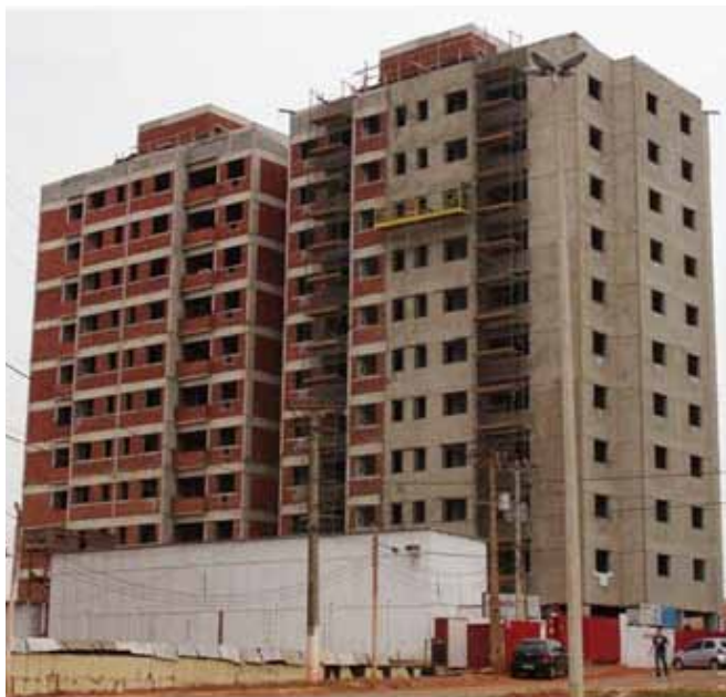
Edifício "B" destinado aos Cabos e Marinheiros
