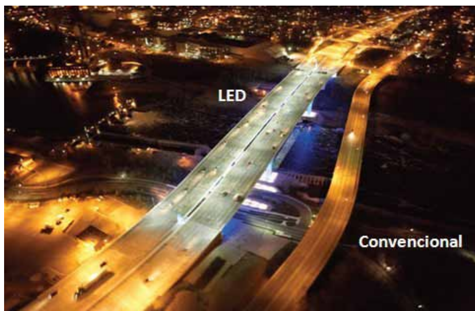
Foto 2 - Ponte St. Anthony Falls, em Minneapolis - EUA (Fonte: Beta LED)
