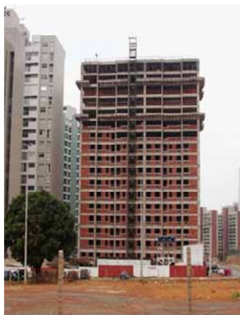
Edifício "D" destinado aos Suboficiais e Sargentos
