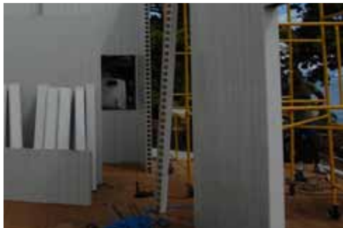
Figura 11 - Painéis de PVC durante a montagem da ECIT.
