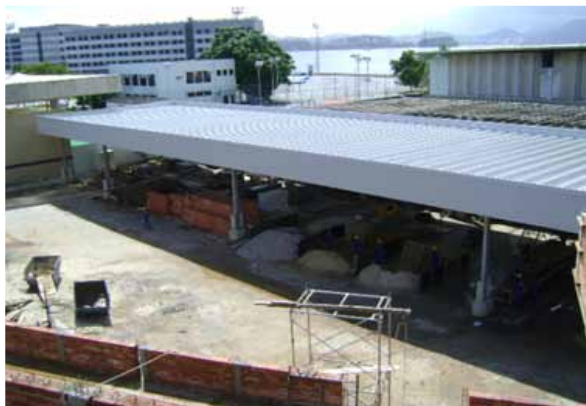
Obras de construção da nova Garagem
