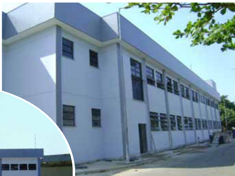
Obras de construção do Prédio de Apoio.
