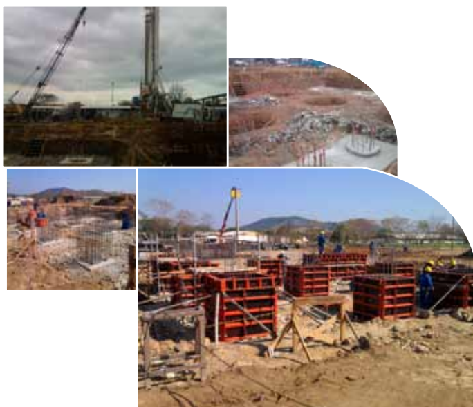
Obras de construção da UFEM
