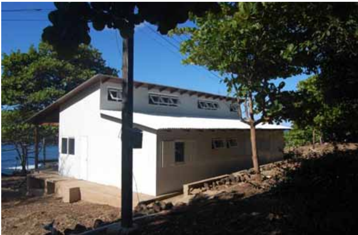
Figura 16 - Vista geral da ECIT na etapa de finalização das obras.
