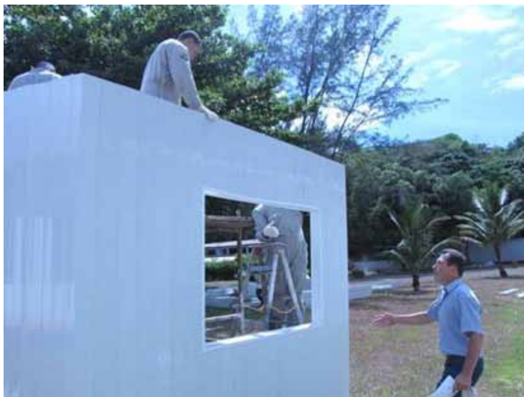
Figura 14 - Montagem da parede de um dos dormitórios.
