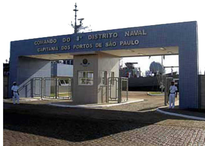
Pórtico de Acesso à CPSP
