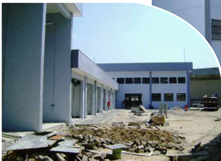
Obras de construção do Prédio de Apoio
