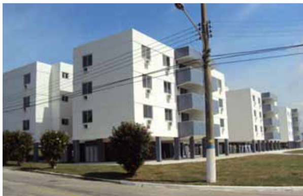
Edifícios Tamoio I, II e III
