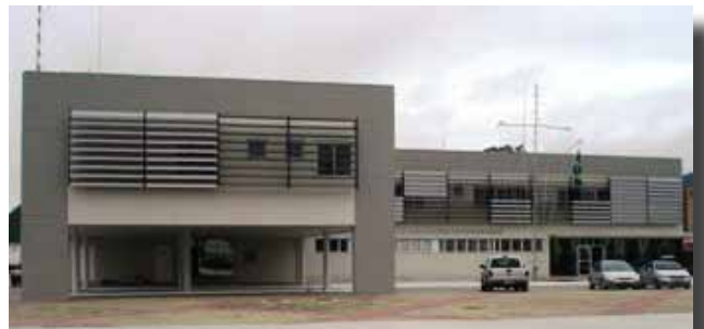
Figura 4 – Elementos de proteção solar (brises móveis) aplicados na fachada da Nova Sede da Delltajá.
