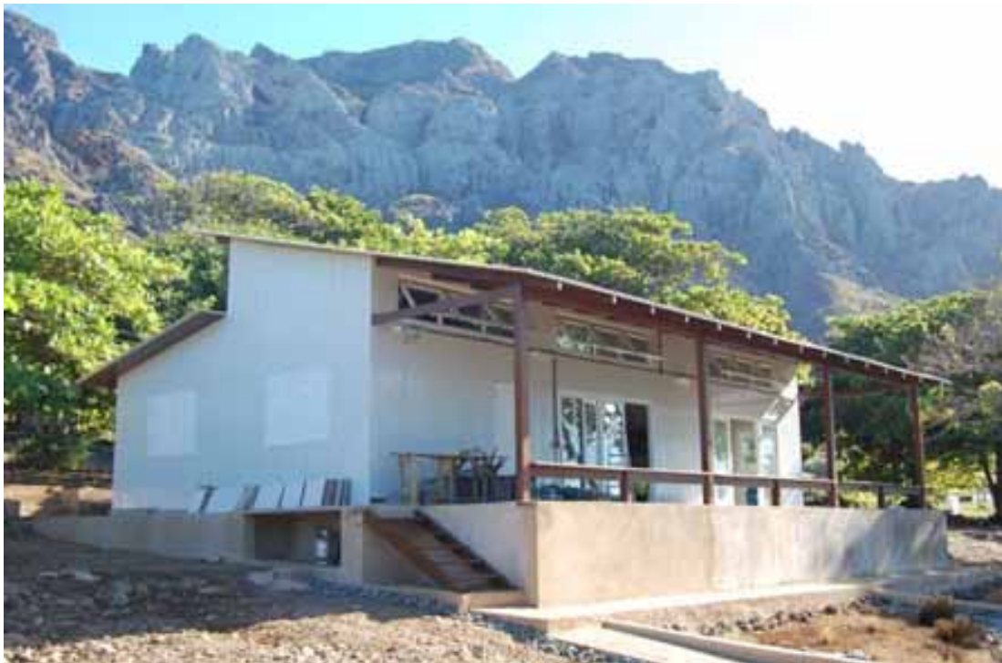
Figura 15 - Vista geral da ECIT na etapa de finalização das obras.
