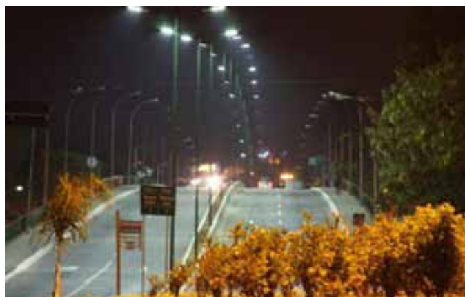
Foto 1 - Ponte Rosinha Fillipo, em Guaratinguetá, SP (Fonte: FEG-UNESP)
