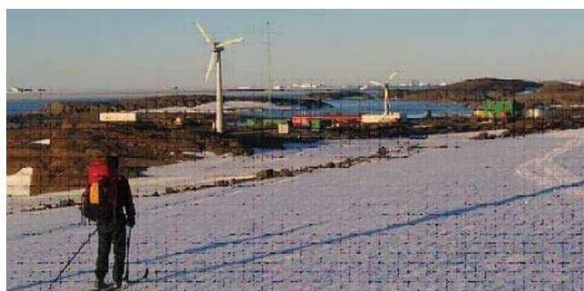
Figura 1 - Parque eólico em operação na estação MAWSON, da Austrália. Dois aerogeradores de 300kW chegam a atender 90% da carga da estação (Fonte: Australia Antarctic Division).
