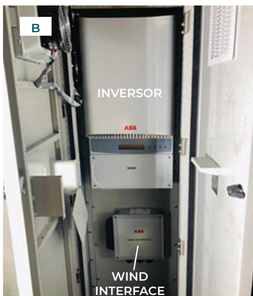
Figura 6. Vista interna da sala do PEG, a direita, e do PER, a esquerda (A). Detalhe do inversor de potência e da "wind interface" (retificador) dos aerogeradores no interior do PER (B). Fonte: SECIRM, 2020.
