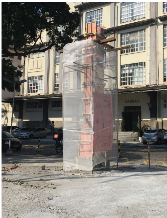
Preparação para a concretagem. Fonte: Acervo próprio.
