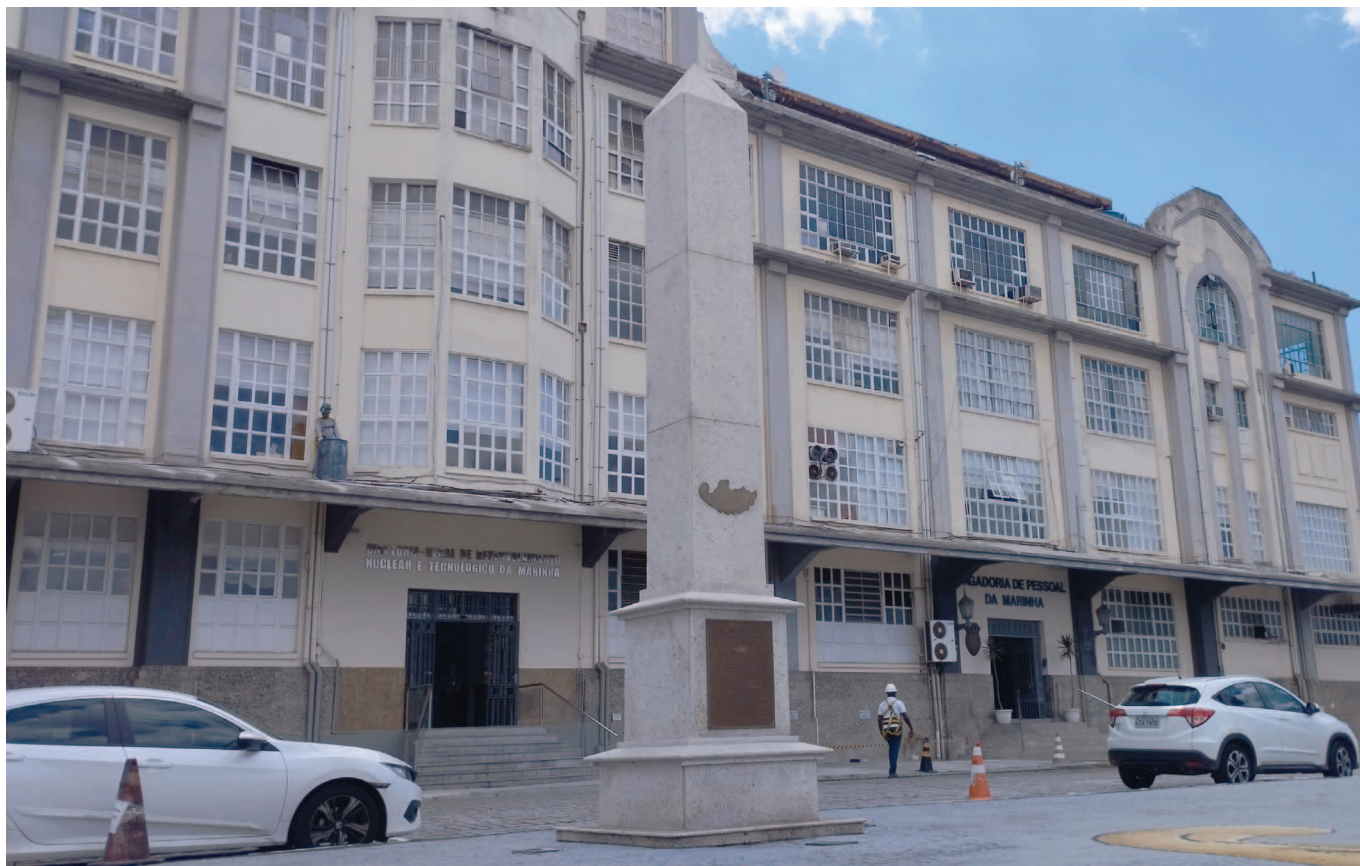
Revestimento em granito. Fonte: Acervo próprio
