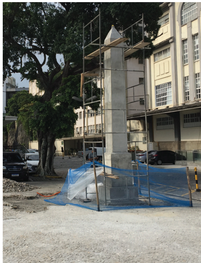
Concretagem concluída. Fonte: Acervo próprio.
