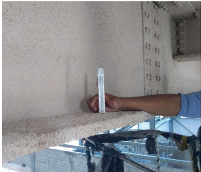
*Ensaio de medição de espessura da argamassa projetada.*
