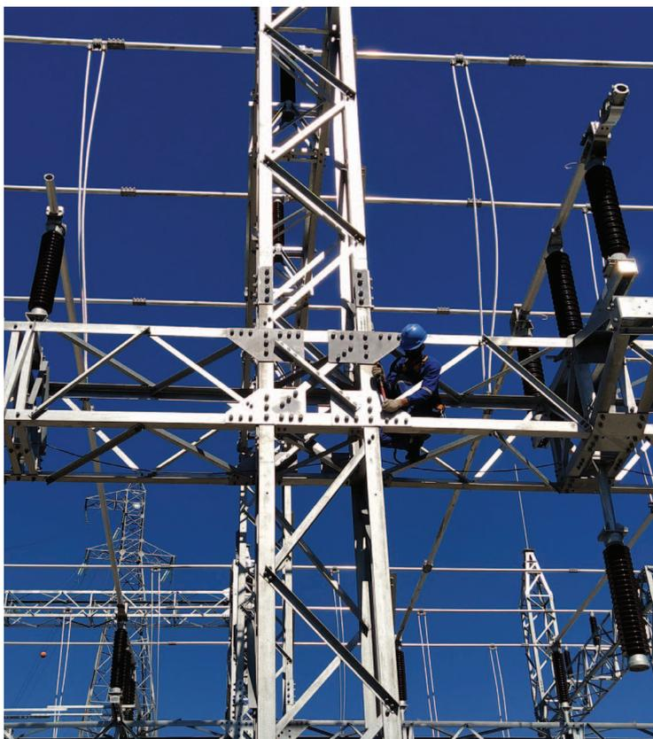
*Aplicação de torque na ligação parafusada.*
