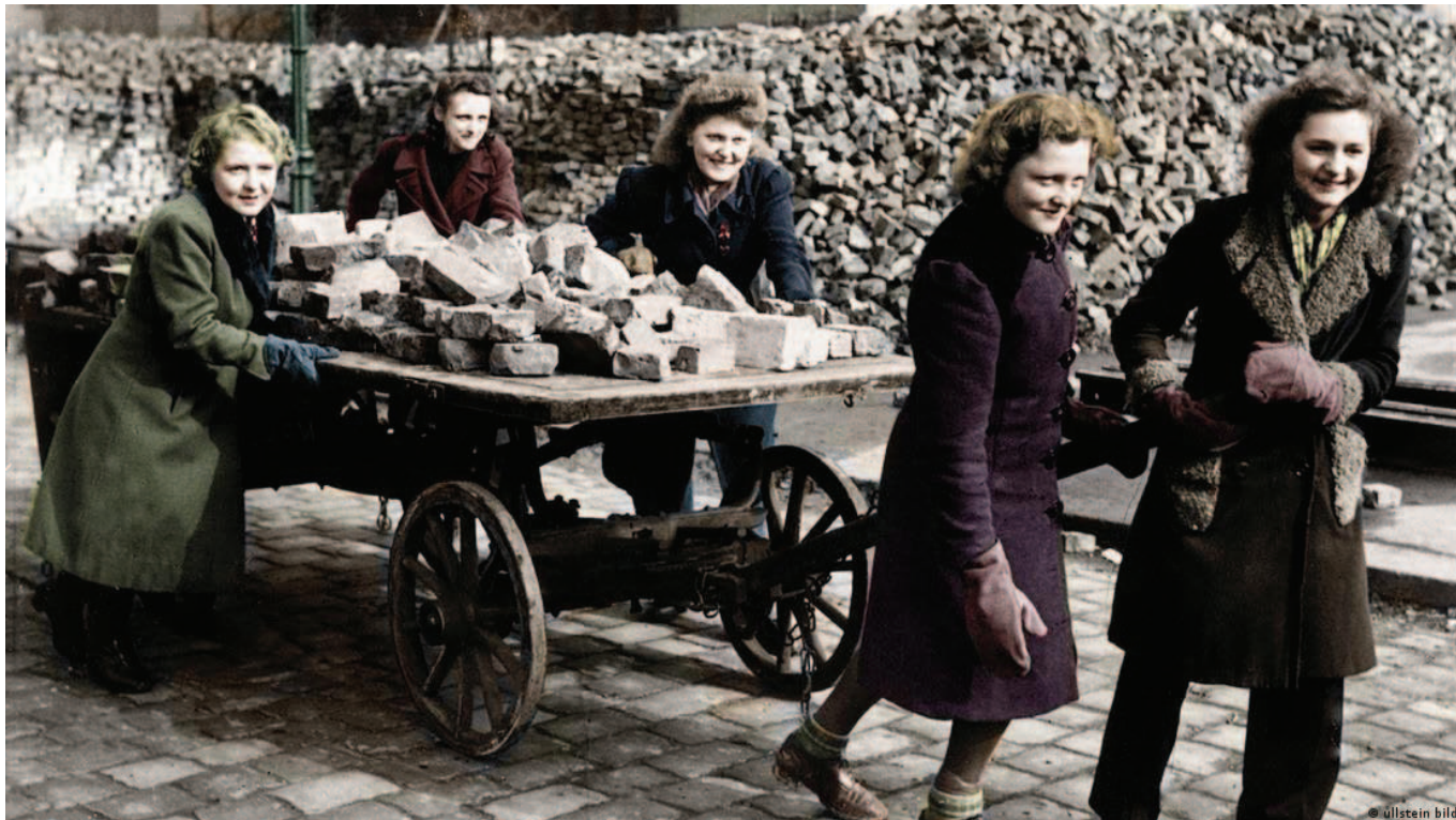
Alemãs trabalhando na reconstrução de Berlim a partir dos escombros da 2ª Guerra Mundial. Fonte: dw.com/pt-br/ - Créditos: Ullstein Bild.
