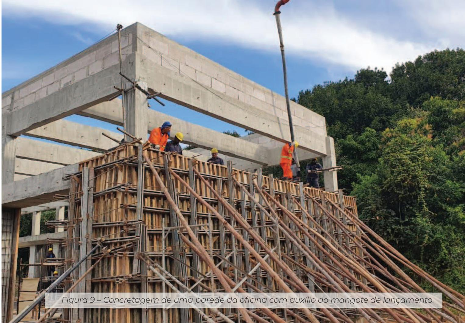
*Figura 9 – Concretagem de uma parede da oficina com auxílio do mangote de lançamento.*
